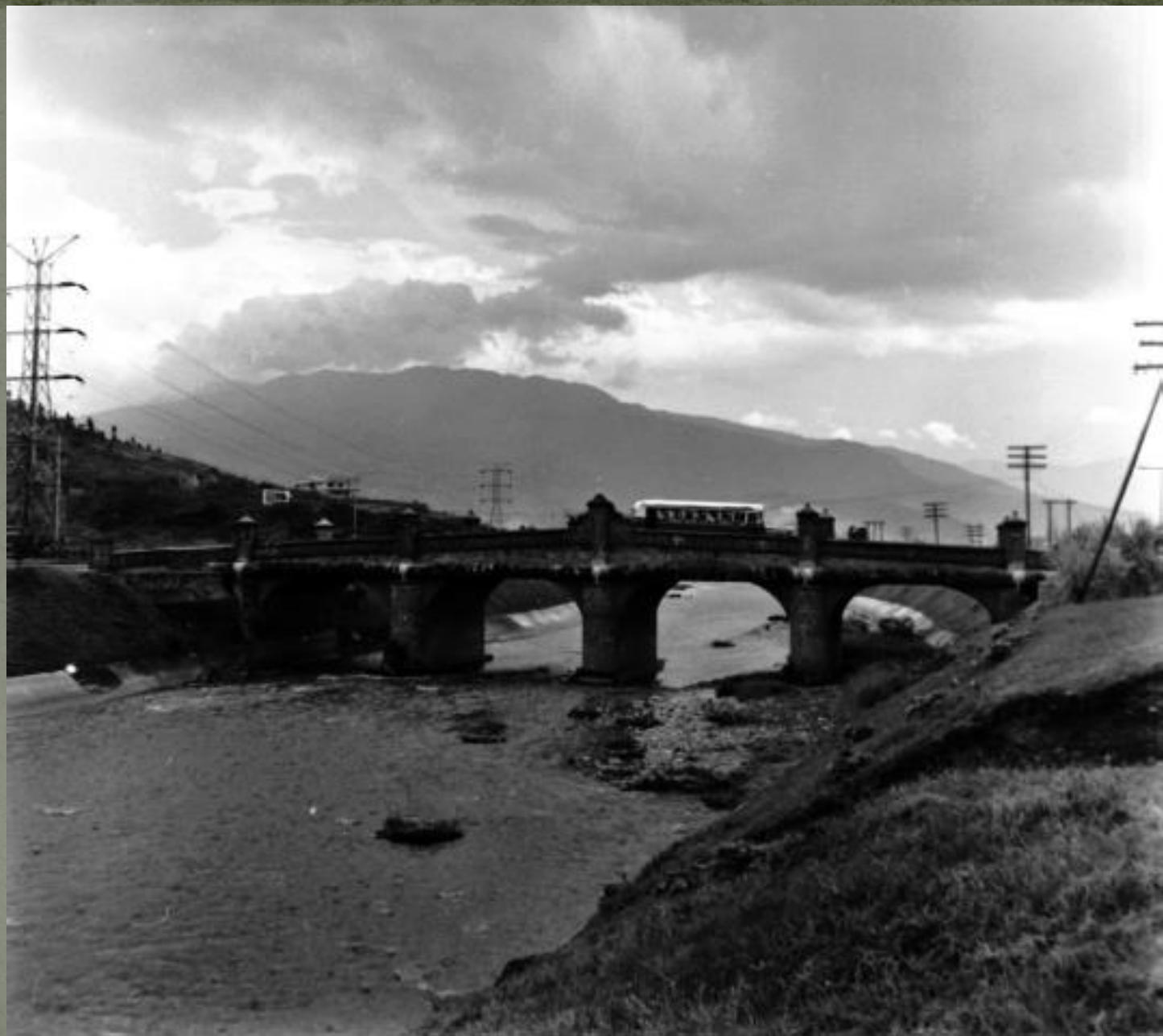
38. Puente de Guayaquil, construido en ladrillos en 1879, por el alemán Henrique Hausler. Después del puente de la calle Colombia, fue el segundo sobre el río Medellín. En 1967 se registra la circulación de vehículos.
