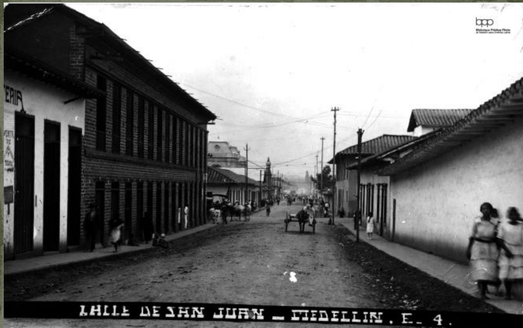
2. Calle San Juan en 1930. En su recorrido del centro al occidente de la ciudad, fue un eje del crecimiento urbano. Al fondo, a la izquierda, sobresale una de las torres de la Estación del Ferrocarril de Antioquia, ubicada en la Plaza de Cisneros.
