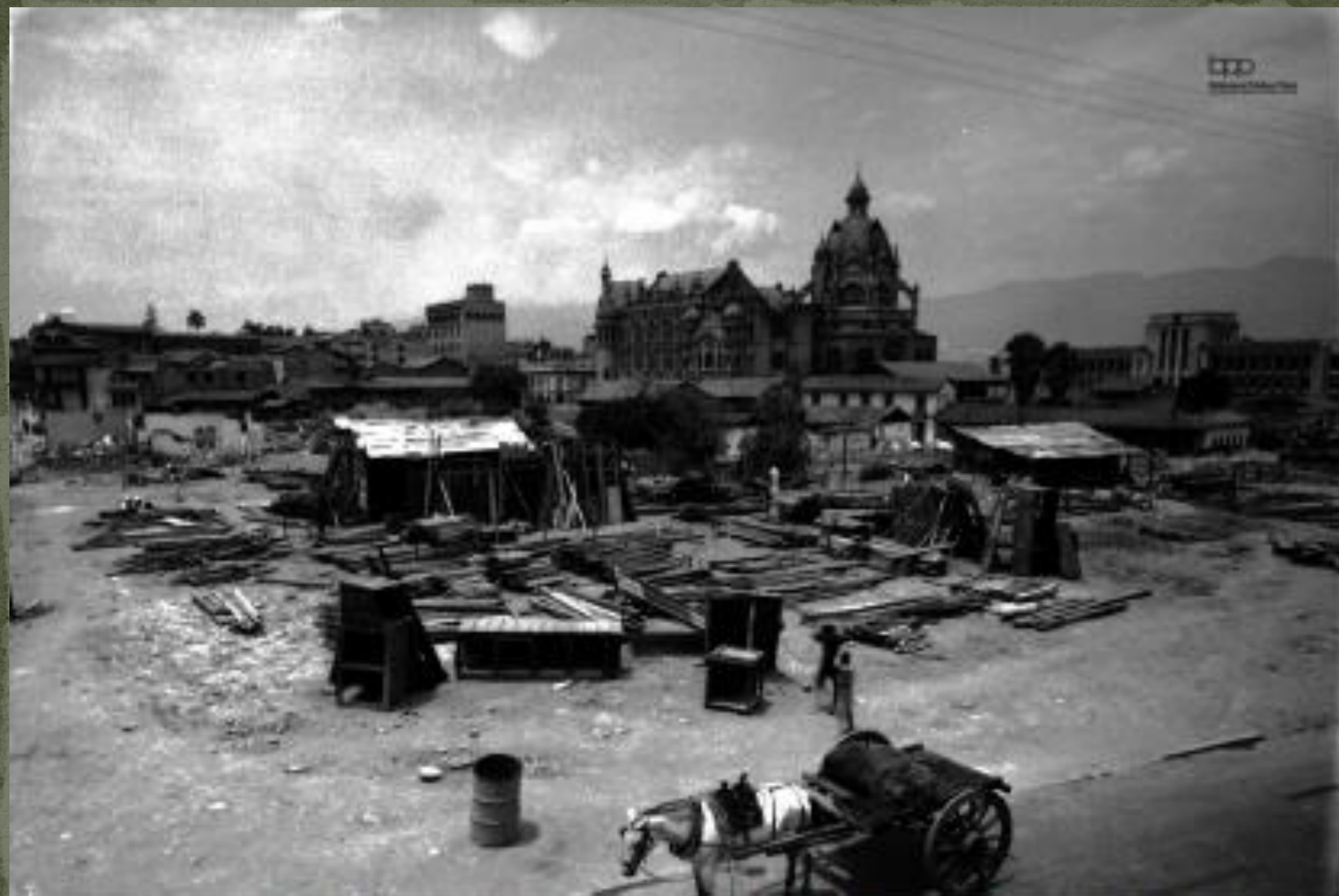
29. Inicio de las obras para la construcción del Hotel Nutibara en los años cuarenta del siglo XX.
