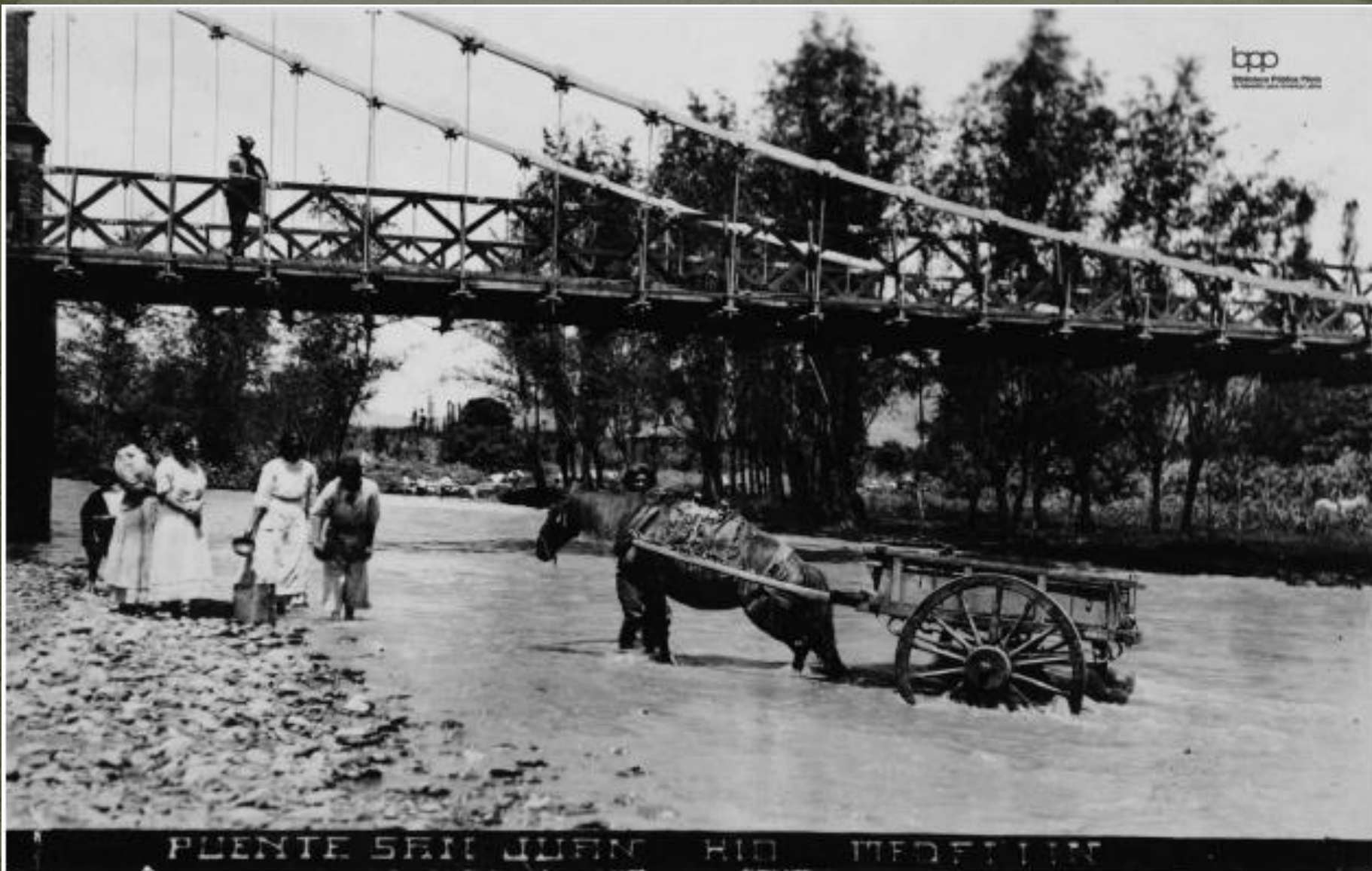
3. Puente de la avenida San Juan sobre el río Medellín, 1920. Obra del ingeniero antioqueño Antonio J. Duque. Estructura colgante construida en metal y madera que fue demolida para dar paso al Tranvía Municipal.
