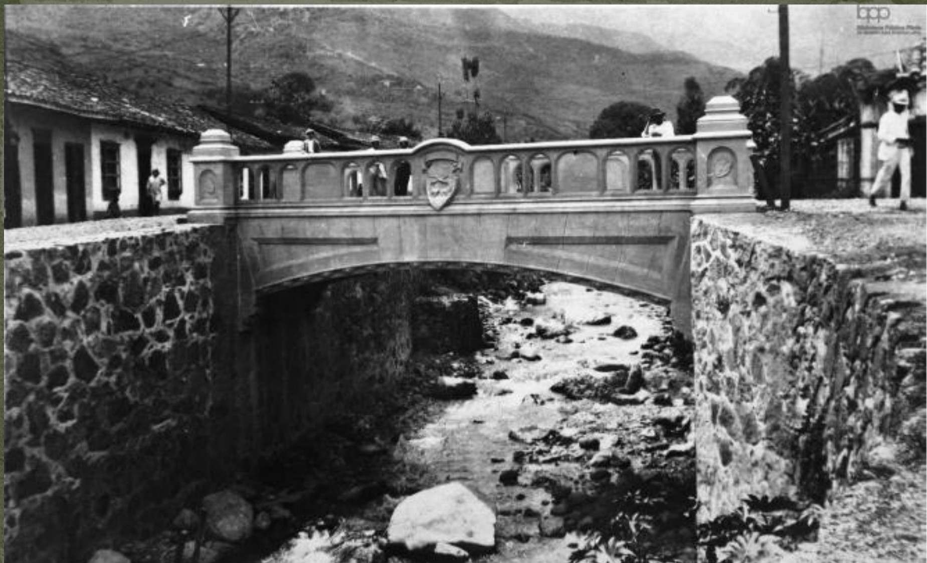
6. Puente de La Toma sobre la quebrada Santa Elena a comienzos del siglo XX. Llamado así por estar localizado en el punto donde, en el siglo XIX, estuvo una bocatoma del acueducto. Fue uno de los doce puentes construidos a lo largo del trayecto de la quebrada.
