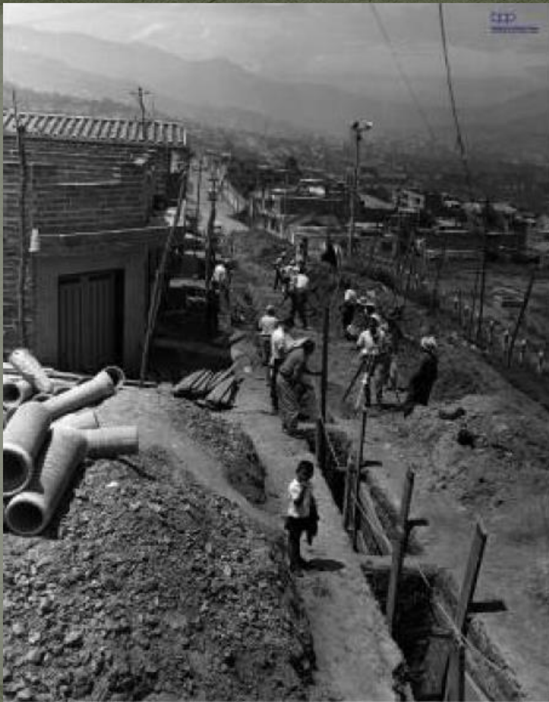
BPP-F-016-0090. 84. Programa de Rehabilitación de barrios adelantado por Empresas Públicas de Medellín. Construcción de red de alcantarillado en 1968.
