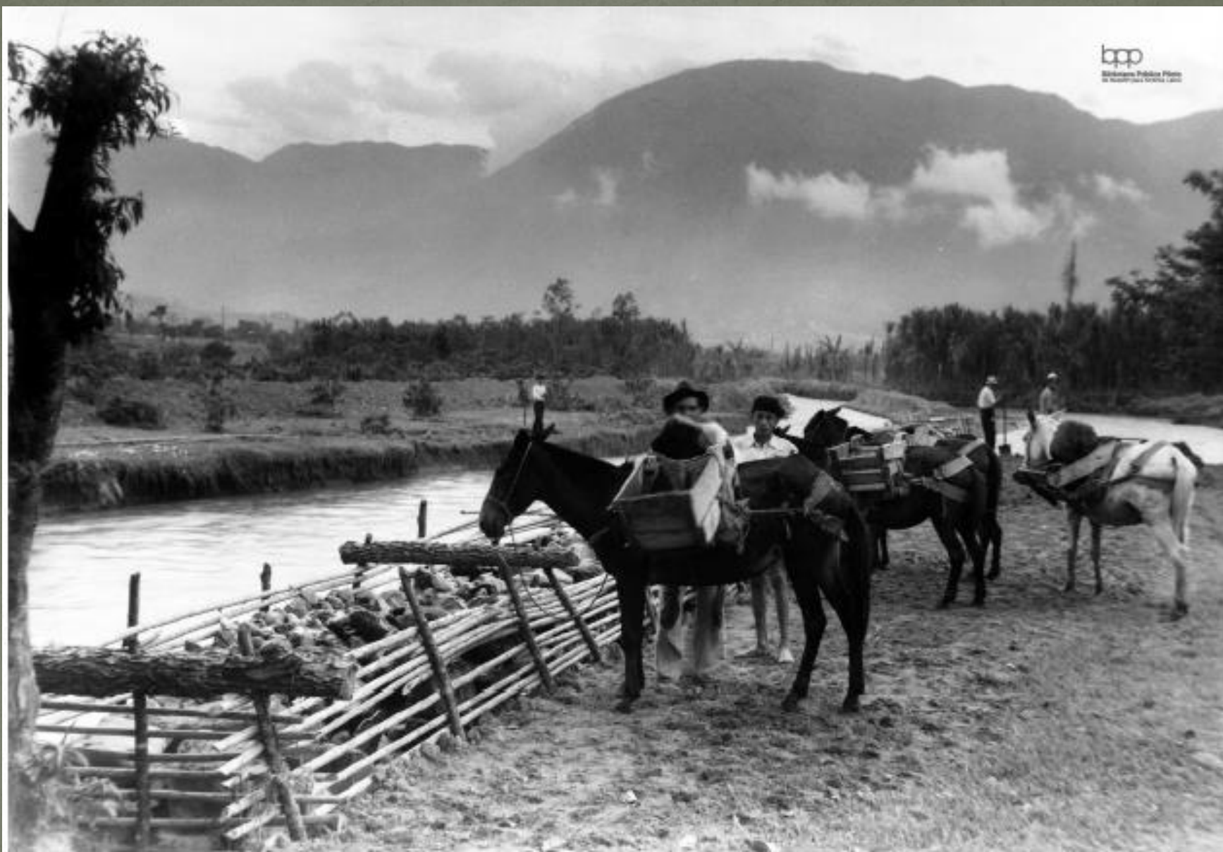
4. Trabajadores y mulas en las orillas del río Medellín, a comienzos del siglo XX. Con las obras de rectificación del cauce se buscó controlar las frecuentes inundaciones que inhabilitaban los terrenos cercanos al río, para la construcción.
