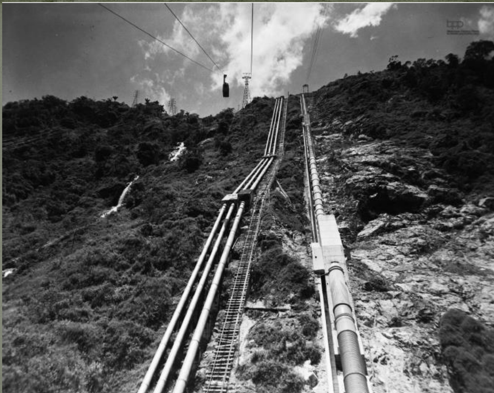
12. Instalaciones de la Central Hidroeléctrica de Guadalupe en 1962.
